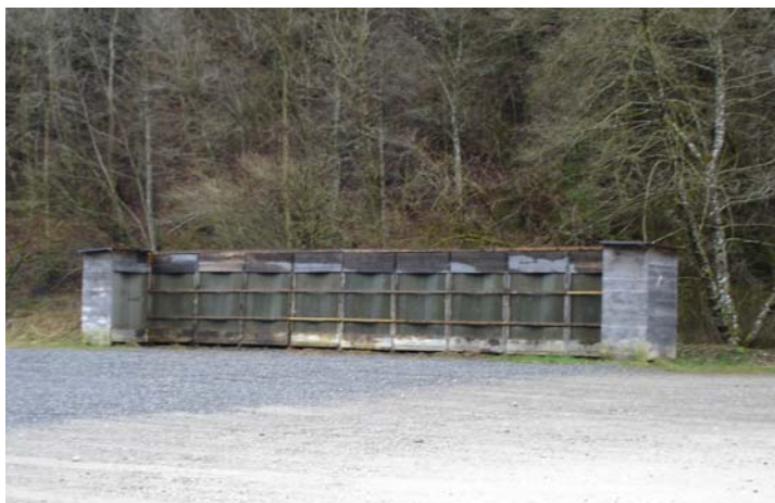
Abbildung 9: Blick Richtung Südosten; Kugelfangkasten.
