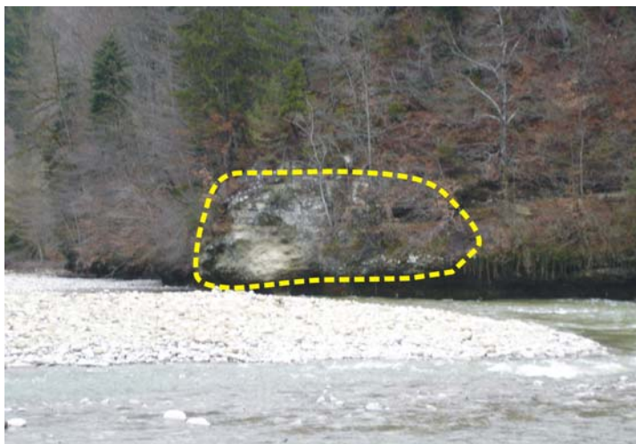
Abbildung 15: Zielort Ruchmüli Nord Inf 2, Blick Richtung Nordosten.
